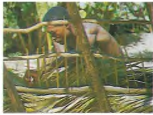
Jamaikaner beim Hausbau.
