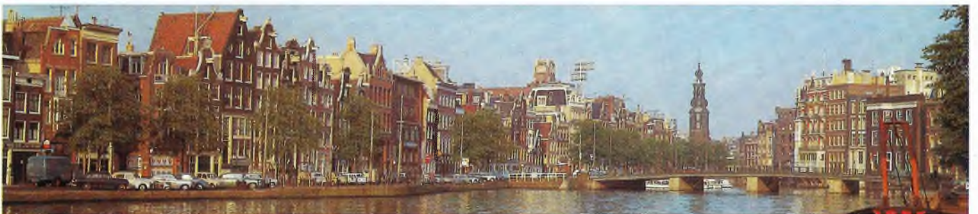
Auf Millionen von Pfahlrosten ist die niederländische Hauptstadt Amsterdam errichtet. Ihre Grachten sind oft Binnenhäfen.
