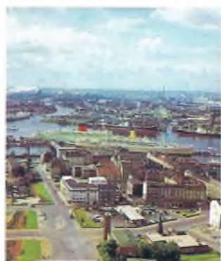
Blick von der Michaeliskirche auf die ausgedehnten Anlagen des Hamburger Hafens.
