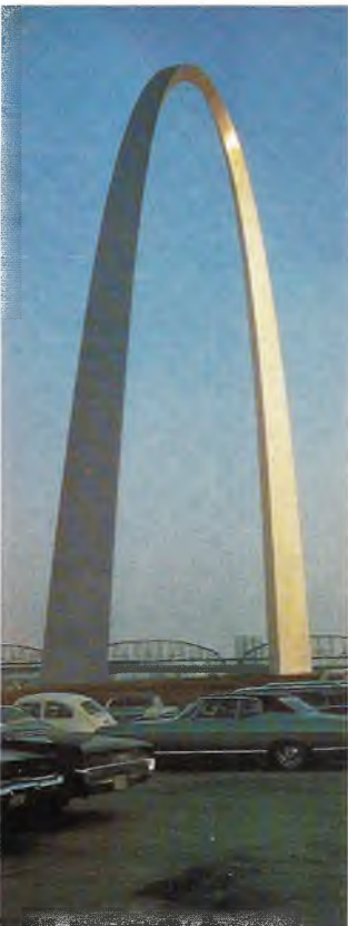
In St. Louis steht der »Gateway«, eine 210 Meter hohe kühne Stahlkonstruktion. Er symbolisiert die Expansion der USA nach Westen.
